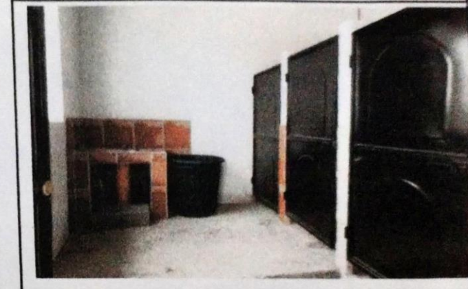
Foto 4: instalacion de servicios sanitarios para niños
